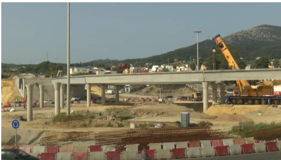
Obras en el Acceso Sur. / FOTO: AAM
