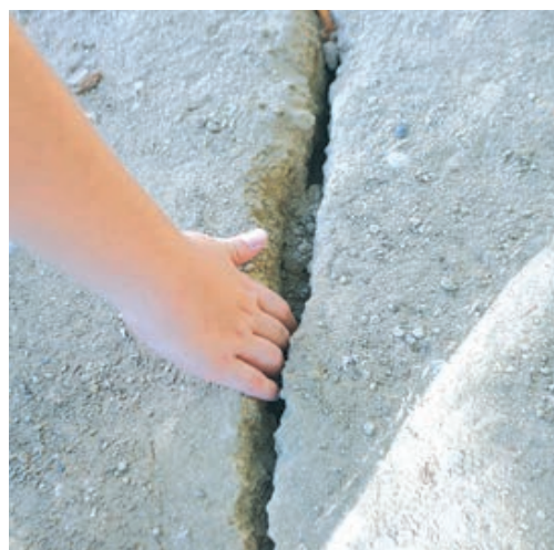
FOTO_ Tony Alcántara A l'esquerra, una gran rasa per solucionar el problema i, a la dreta, detall de l'esquerda provocada per la filtració
