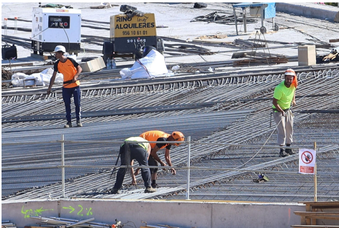
Las obras del Acceso Sur (Junio de 2025). / Vanessa Pérez
