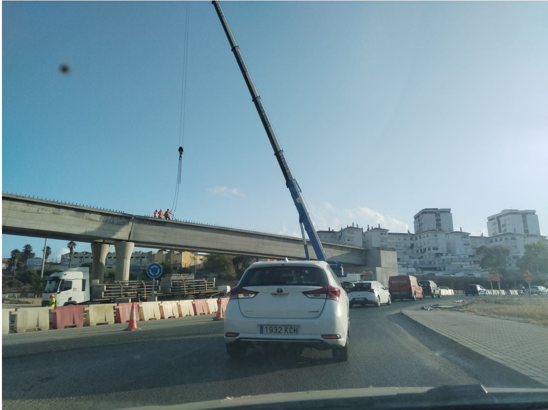
Obras del Acceso Sur.
