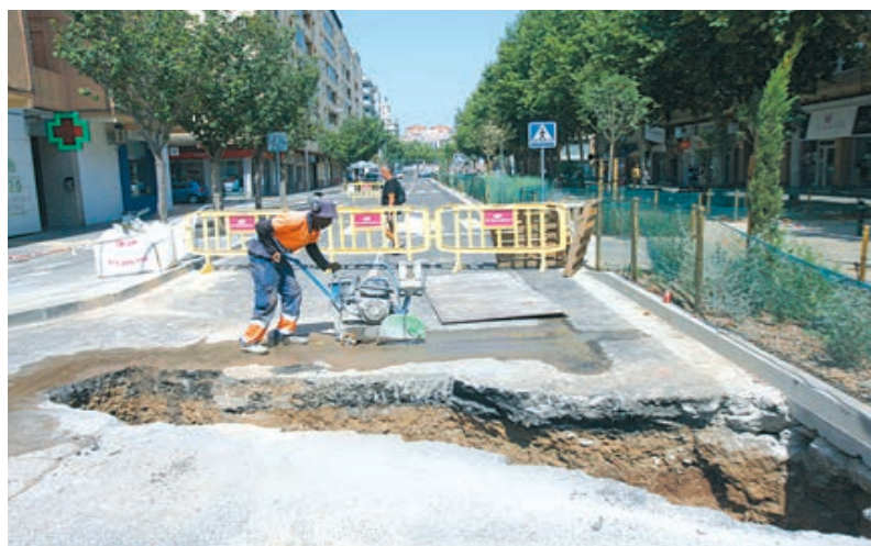
FOTO_ Tony Alcántara A l'esquerra, una gran rasa per solucionar el problema i, a la dreta, detall de l'esquerda provocada per la filtració
