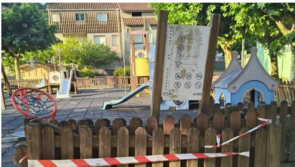
El mal estado del parque de Aldán pone en riesgo a los niños
